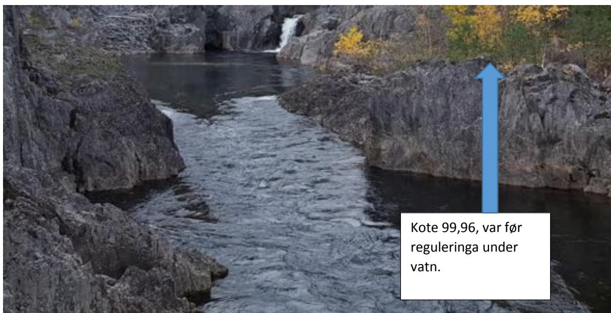
Biletet viser den kanalen som blei sprengt i 1969. Då blei Helveteshylen senka med 3,2- 3,4 meter og stryket mellom Helveteshylen og Åmotehylen blei sprengt bort. Høgaste punkt i dag er på kote 99,96. Den kota var alltid under vatn sjølv ved lågvassføring.
