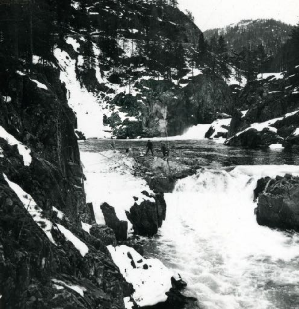
Figur 7. Fotografi fra anleggsperioden for byggingen av Lio kraftverk. På dette bildet er nedstrøms elvestrekning mot Åmøtehylen senket, noe som medførte økt fossefall i det nederste fossetrinnet. Det ble i sin helhet sprengt bort, og disse tiltakene definerer dagens senkede vannspeil i Helveteshylen.
