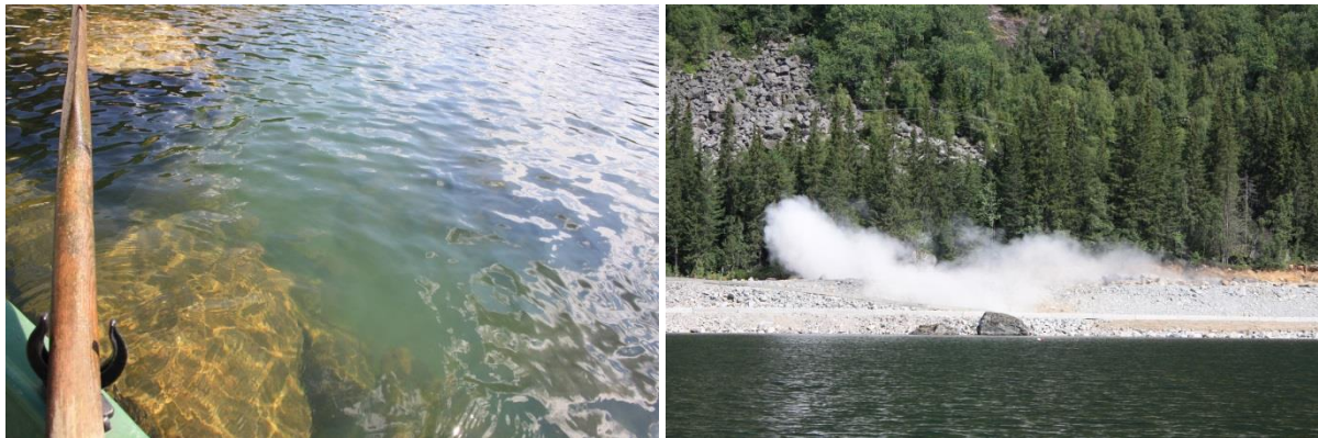
Figur 7. Bilete frå Tveitevatt inne ved land utanfor steinfylling og vegarbeid med sprenging. Foto Anne Nylend.
