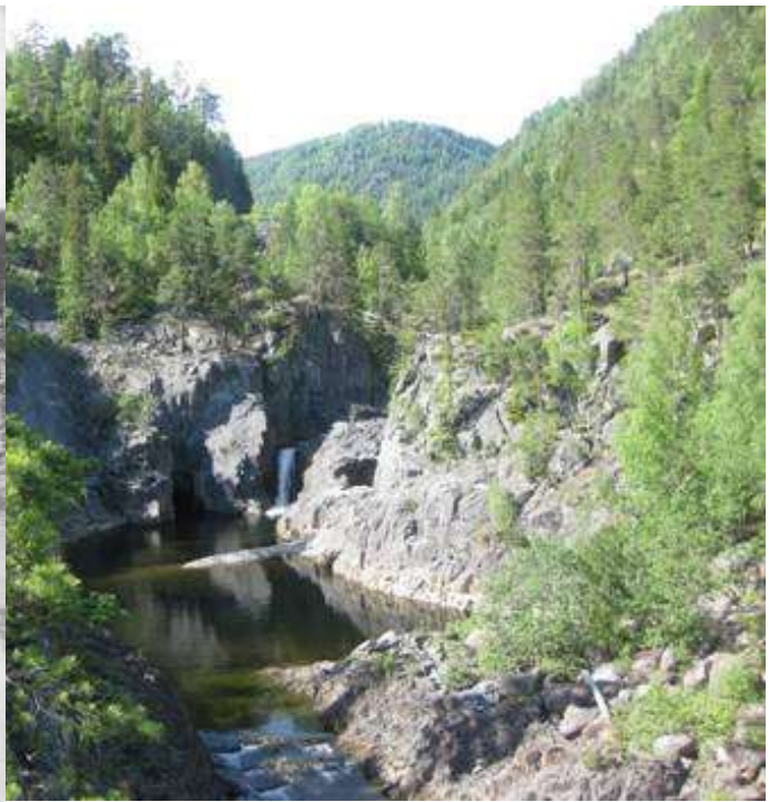
Helvetesfossen og utløp Lio kraftstasjon i dag
